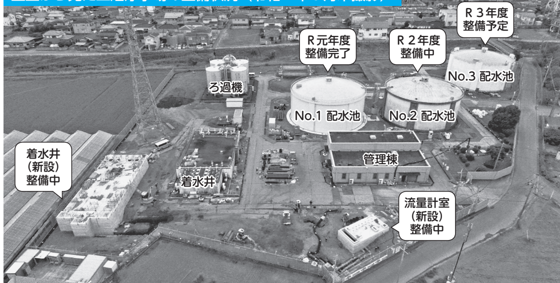
上空から見た皿沼浄水場の整備状況（令和2年8月末撮影）
