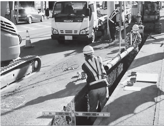
水道管布設替工事の様子
