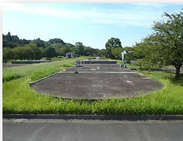
○オキシレーションディッチ
