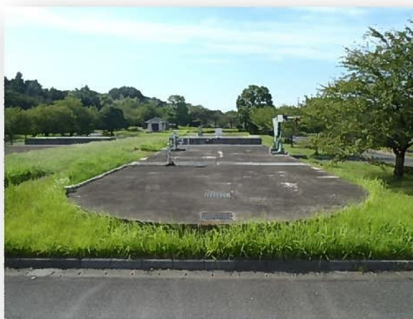
○オキシレーションディッチ
