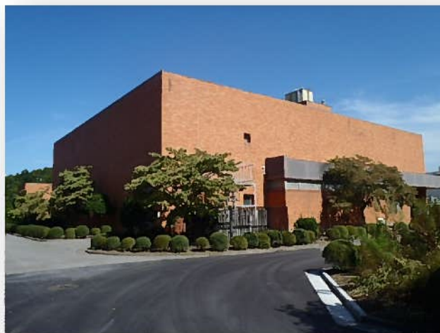
○沈砂池ポンプ棟
