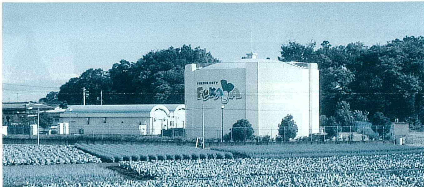
(新仙元山配水場)
