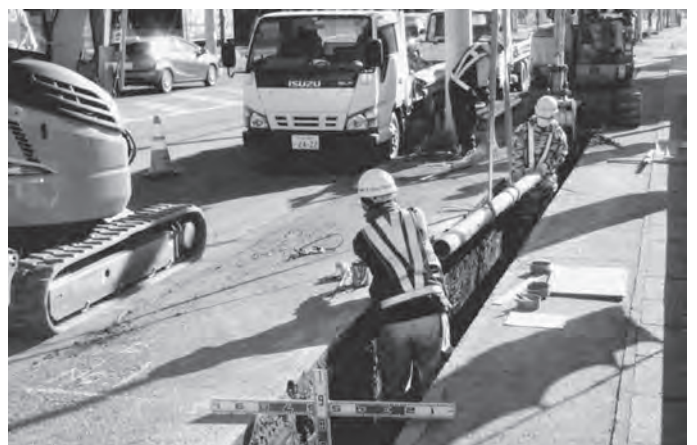
老朽管布設替の様子
