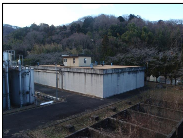
第2配水場 既設配水池
