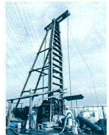
掘削深 約 200 m
