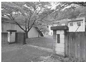
はなぞの だい ずいじょう 花園第2配水場
