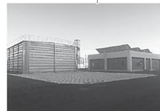
ほんだ ずいじょう 本田配水場
