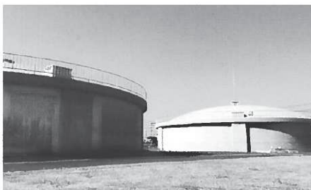
⑤ 処理した水を一時貯めておきます。
