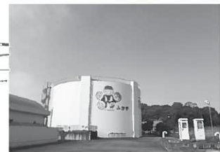
しんせんげんやま ずいじょう 新仙元山配水場
