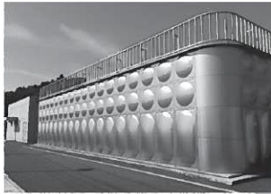
いまいずみ ずいじょう 今泉配水場
