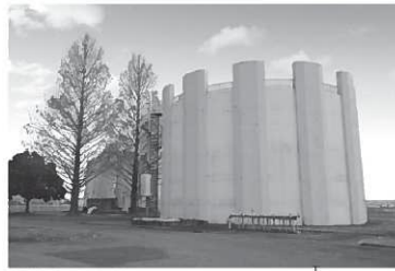
まえがわ じょうすいじょう 前川原浄水場
