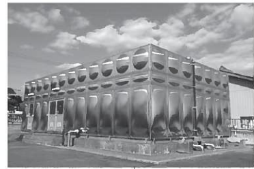
まえこ じょうすいじょう 前小屋浄水場
