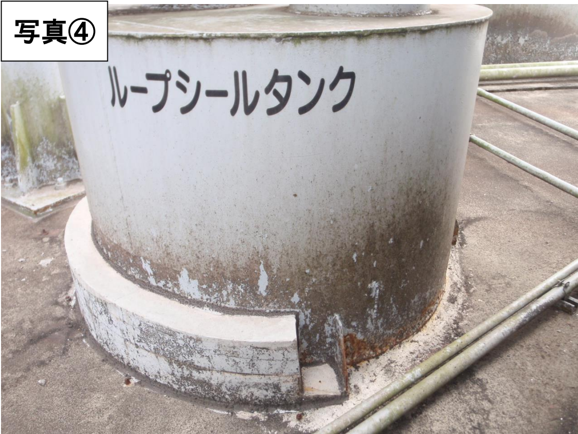
除鉄・徐マンガン装置 腐食・補強状況
