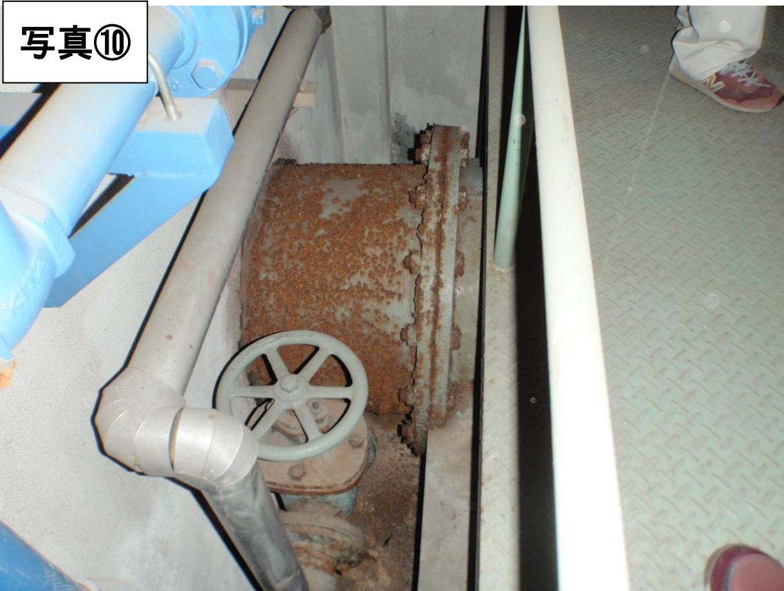
管理棟 配水ポンプ室内部配管劣化状況
