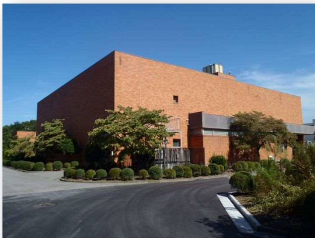
○沈砂池ポンプ棟
