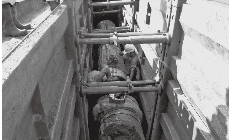
岡部地区内 水道管布設工事の様子
