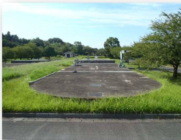
○オキシレーションディッチ
