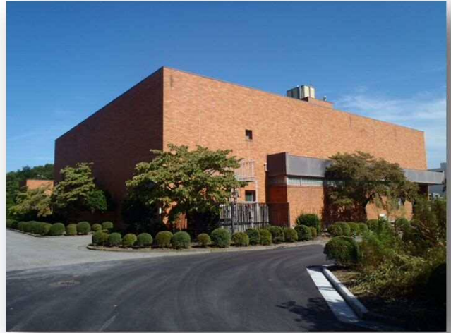
○沈砂池ポンプ棟
