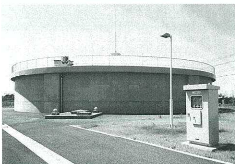
地震に強い構造の配水池と水を蓄える緊急遮断弁（岡部浄水場）
