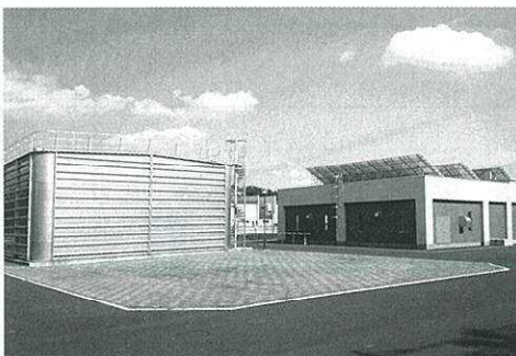
荒川南地域へ安定した給水を行う配水場（本田配水場）
