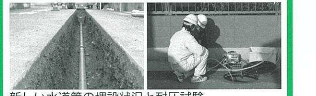
新しい水道管の埋設状況と耐圧試験
