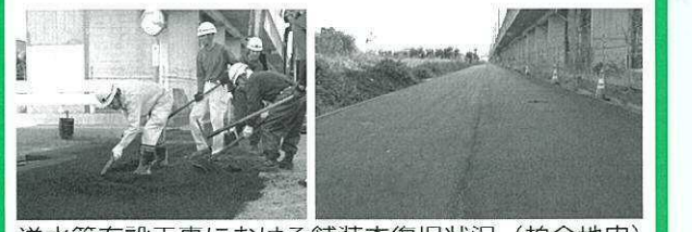
送水管布設工事における舗装本復旧状況 (柏台地内)
