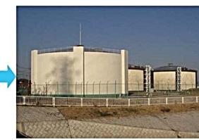
⑥配水池 処理された飲料水をためておくタンク。
