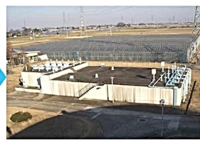
②着水井③薬品混和池 地下水を受け入れ、水の量を計測し、消毒剤で滅菌する。
