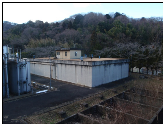
第2配水場 既設配水池
