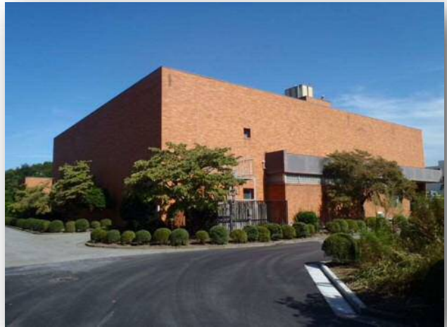
○沈砂池ポンプ棟
