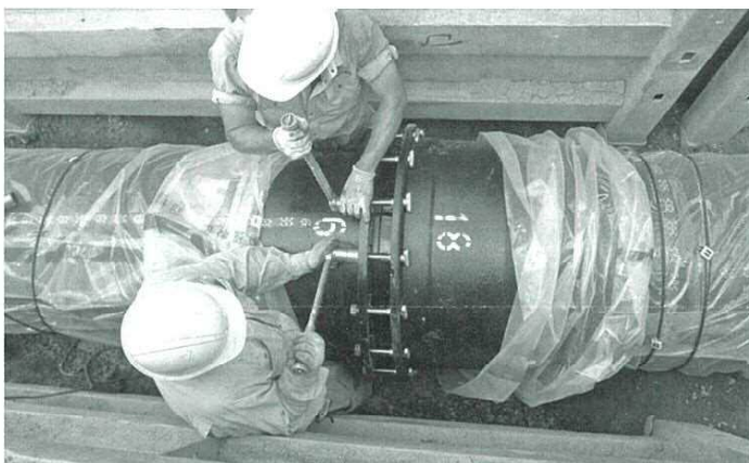
①～③管路更新工事の様子
