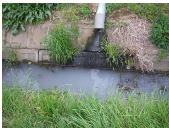
排水による汚染の状況
