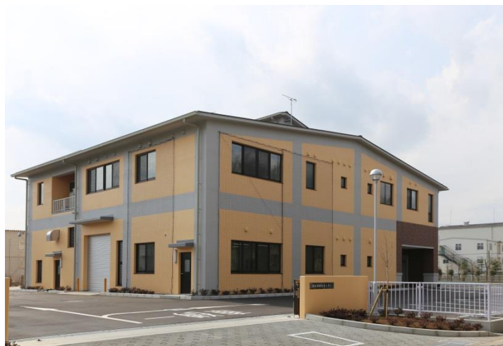
深谷市衛生センター(平成28年4月供用開始)
