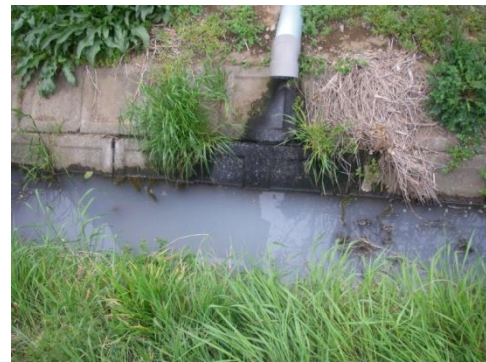
排水による汚染の状況
