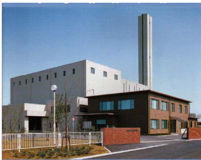
大里広域市町村圏組合立深谷清掃センター
