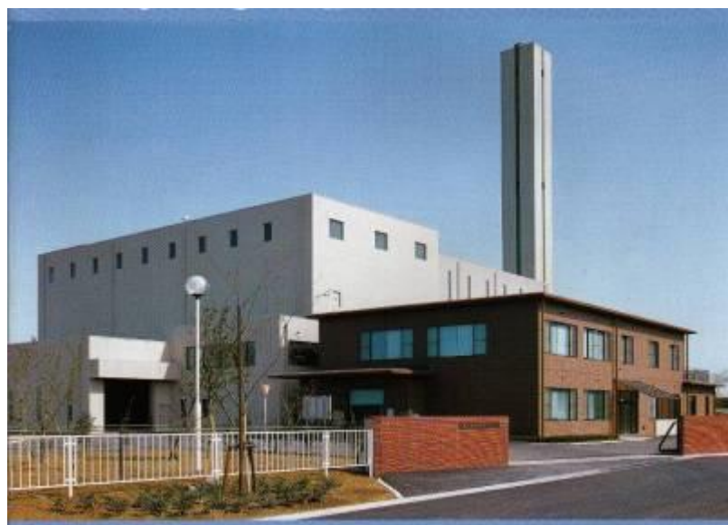
深谷清掃センター
