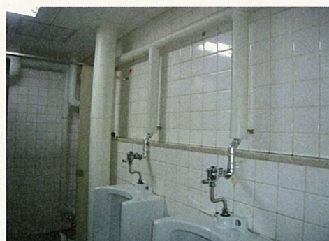
不具合により修繕を行ったトイレ
