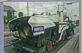
アスファルトフィニッシャー
