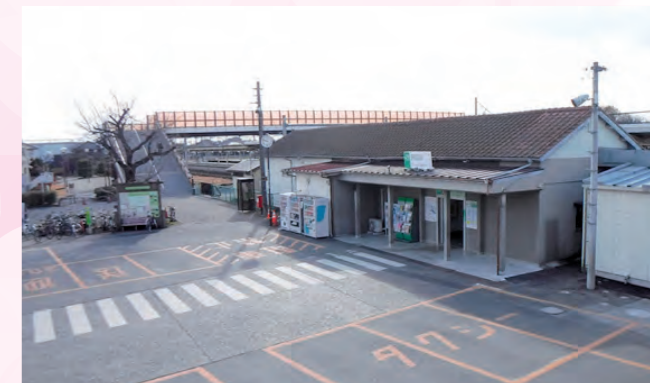
岡部駅橋上駅舎化事業 1,749万8千円
