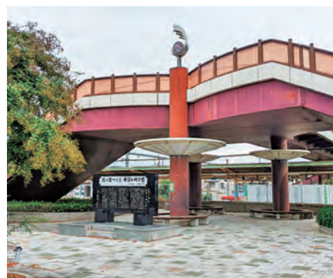
岡部駅ホームに架かる南北連絡通路
