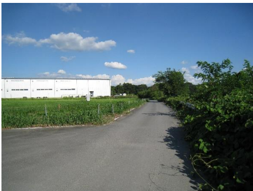
南西方向から
