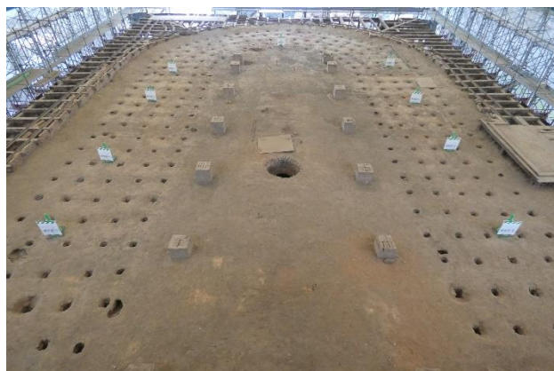
小屋組解体完了後（煙突付近から）
