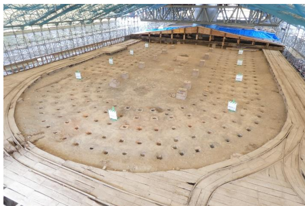
小屋組解体完了後
