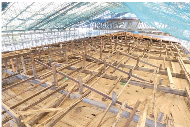
屋根鉄板の撤去後
