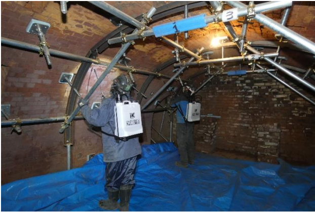
含浸強化剤の吹き付け作業
