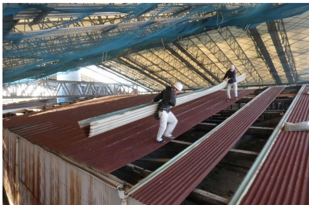
屋根鉄板の撤去作業
