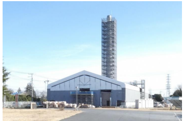
煙突に設置された足場
