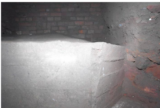
コンクリートの煙突基礎
