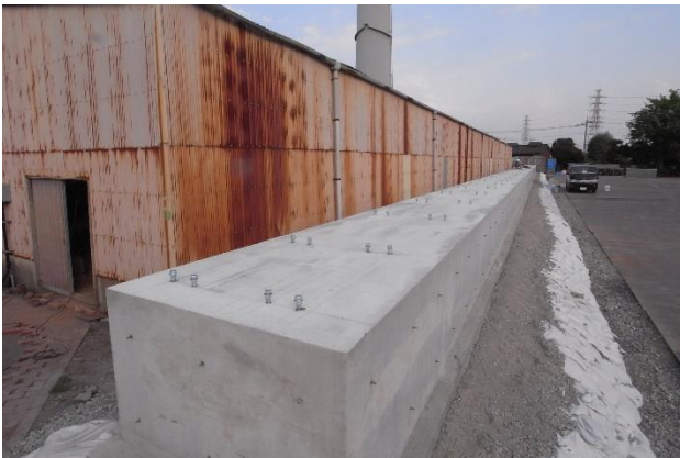
素屋根基礎の設置状況
