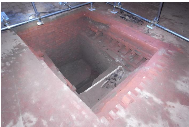
煙突基礎確認のための掘削状況
