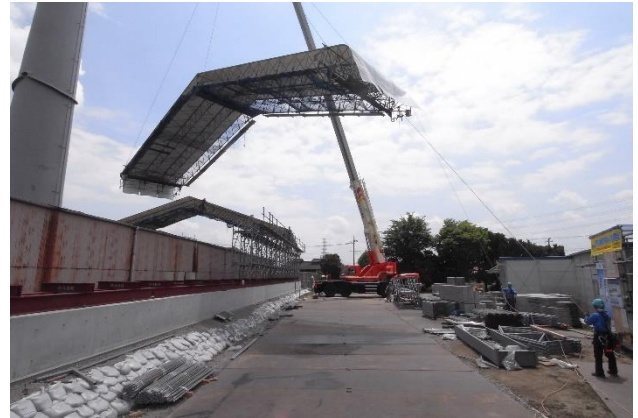
素屋根小屋組みの架設
