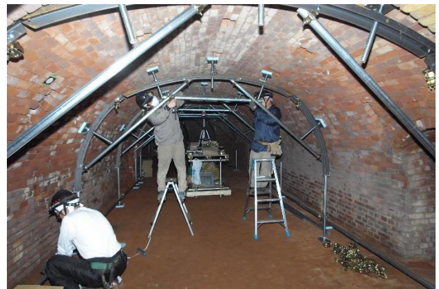
窯内部のサポート設置
