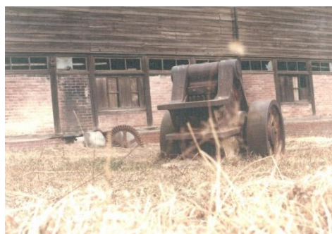
【参考】ホフマン輪窯4号窯覆屋外壁下部（1978年）
