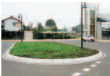
新設された武川駅北口のロータリー（7月中旬の様子）
